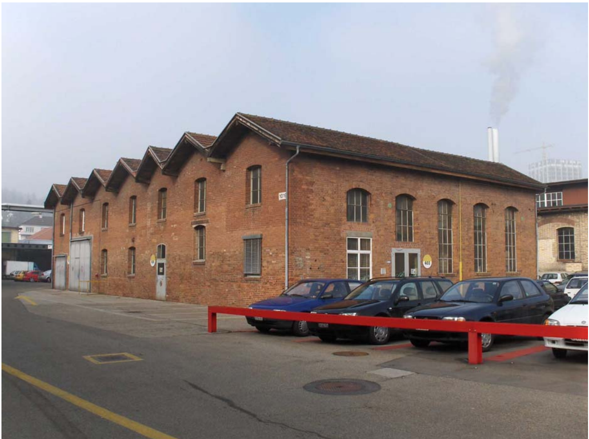
Die neue Heimat der Jugendkirche - Aussenansicht Fabrikkirche im Gebäude 1019 auf dem Sulzerareal
