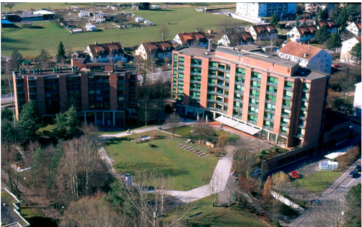
Wohn- und Pflegezentrum Oberwinterthur von 1982, sogleich mit einem verbandseigenen Pfarramt versehen.
