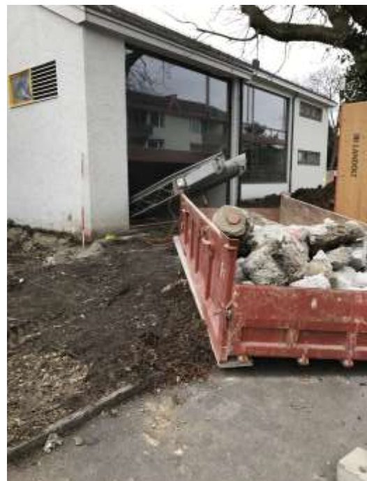
Förderband mit Ausbruchsmaterial Untergeschoss
