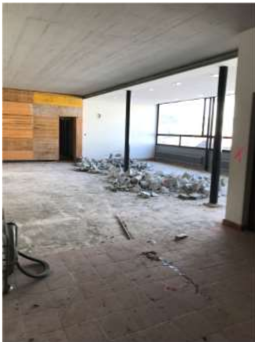
Rückbau Erdgeschoss Sicht auf ehemalige Garderobe
