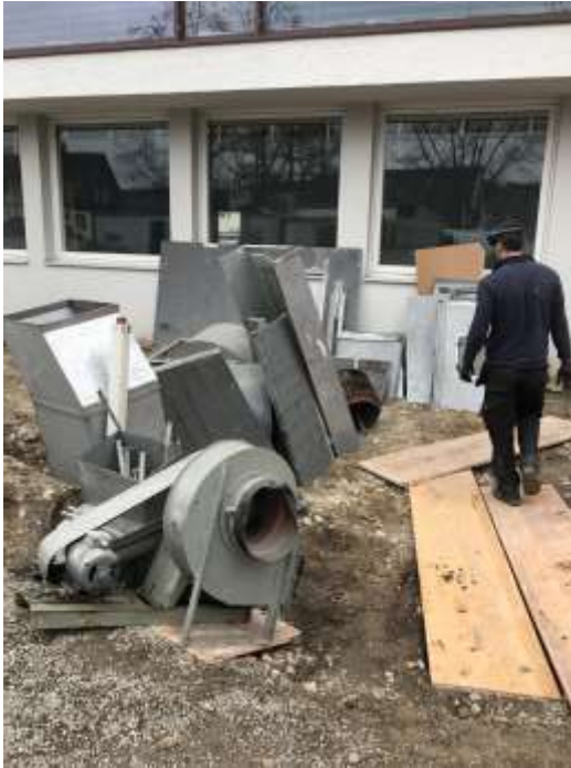
Demontierte Lüftungsschächte
