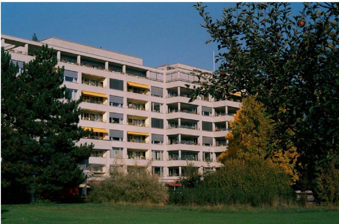
Alters- und Pflegezentrum Adlergarten, mit Pfarramt des Verbandes seit 1976.
